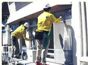
▲清掃作業の様子
