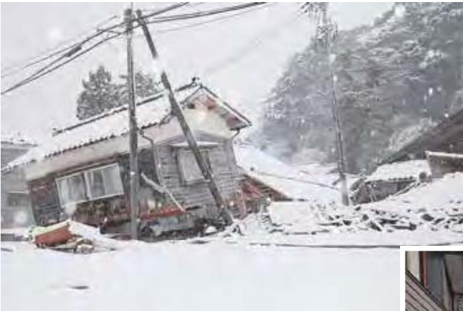
珠洲市三崎町 家屋倒壊
