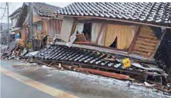
珠洲市内 家屋倒壊
