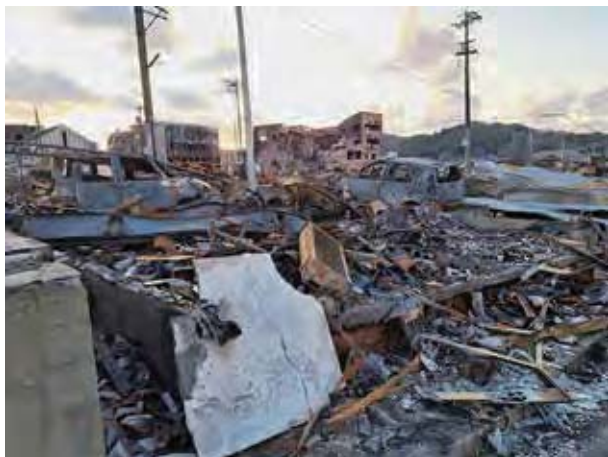
輪島市朝市通り 火災現場
